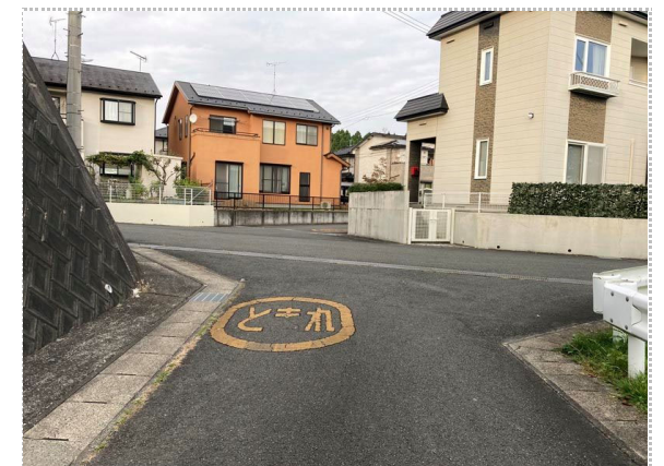
写真12 西側部 中央方向 変状ほぼなし
