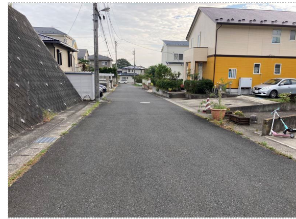
写真2 東側部 下流方向 変状ほぼなし
