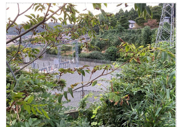
写真16 末端東側 西方向 住宅側は切土
