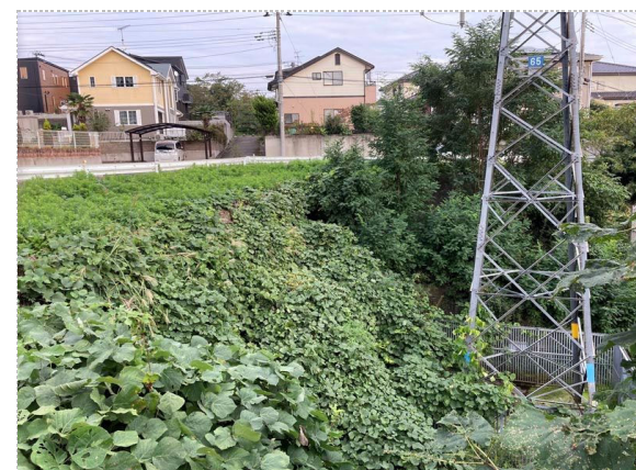
写真14 末端中央 のり面下に鉄塔
