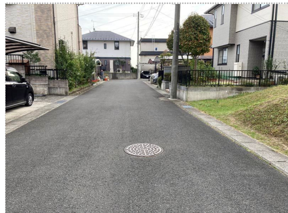
写真5 頭部 主測線方向 変状ほぼなし
