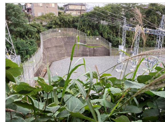
写真15 末端中央 東方向 コンクリート擁壁は健全
