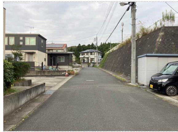
写真1 東側部 範囲外 ブロック積部は切土判定
