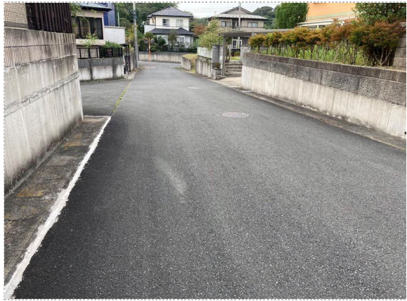
写真18 頭部範囲外 側溝沿い開口補修跡
