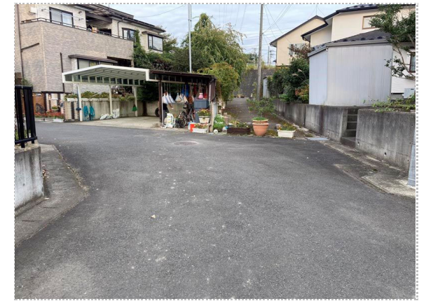
写真4 中央 東方向 変状ほぼなし
