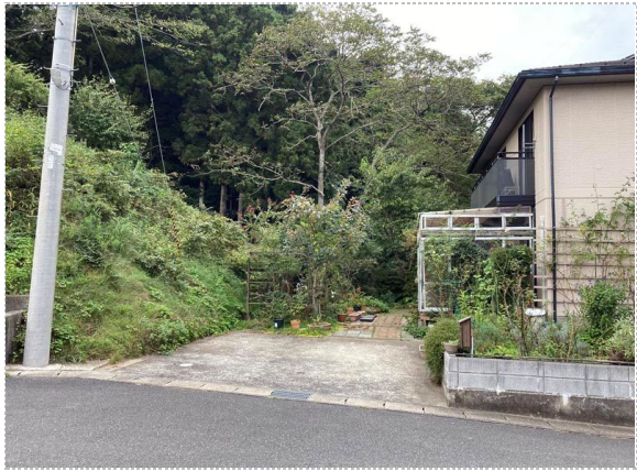
写真20 No.15-2南側部 ほぼ原地盤
