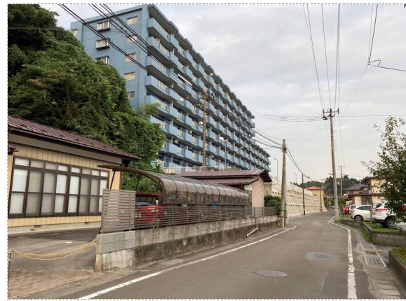
写真1 末端西側 中央方向 植生繁茂部は原地盤
