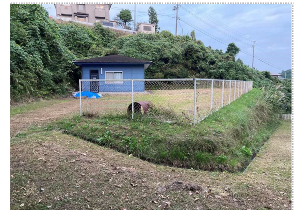
写真24 頭部西側 集会所背後は切土のり面
