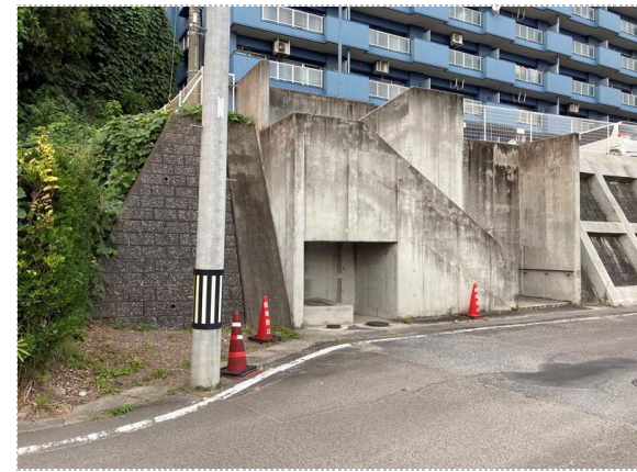
写真2 末端西側 ブロック積・コンクリート構造物に変状なし
