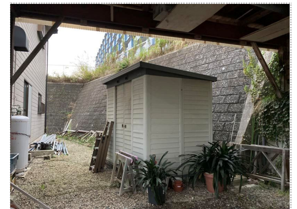
写真12 東側部中央方向 ブロック積に変状ほぼなし
