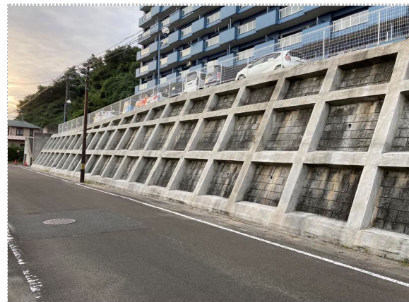
写真5 末端中央 西方向 ブロック積に法枠補強
