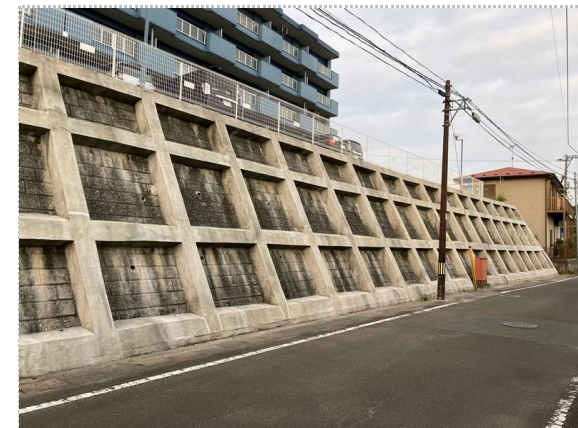
写真7 末端中央 東方向 ブロック積に法枠補強
