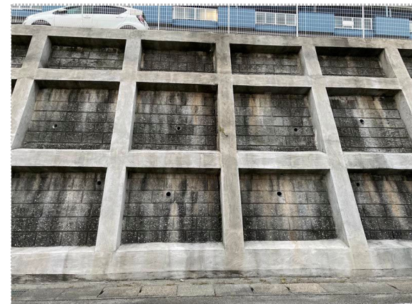
写真6 末端中央 ブロック積に法枠補強
