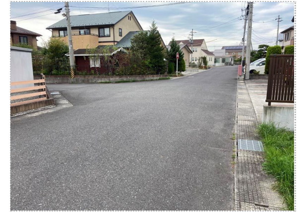
写真20 東側部頭部付近 変状ほぼなし
