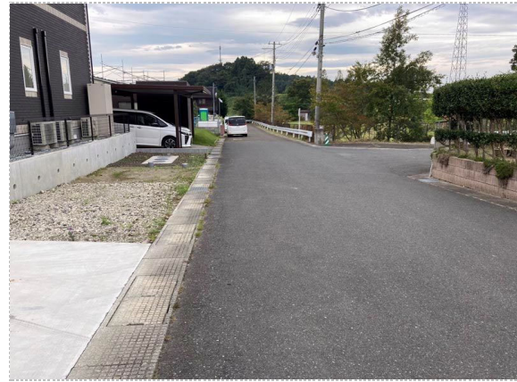
写真33 東側部下流側 変状ほぼなし
