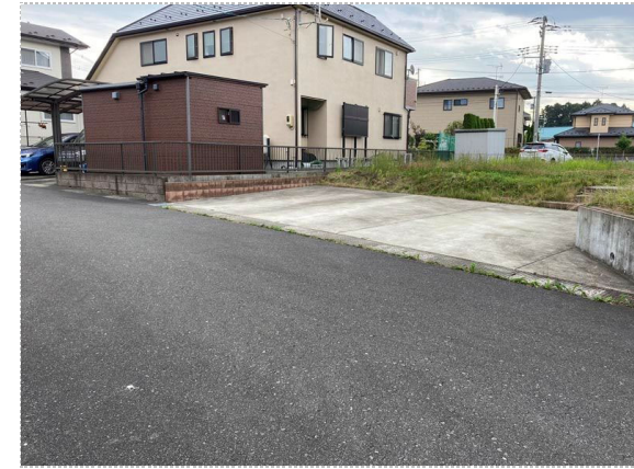
写真19 中央上流側 池を埋めた箇所 変状ほぼなし
