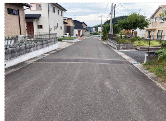
写真30 中央下流側 変状ほぼなし
