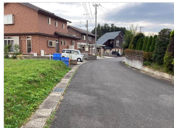
写真14 頭部中央付近 変状ほぼなし
