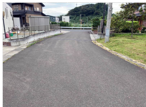
写真29 西側部 調整池方向 変状ほぼなし
