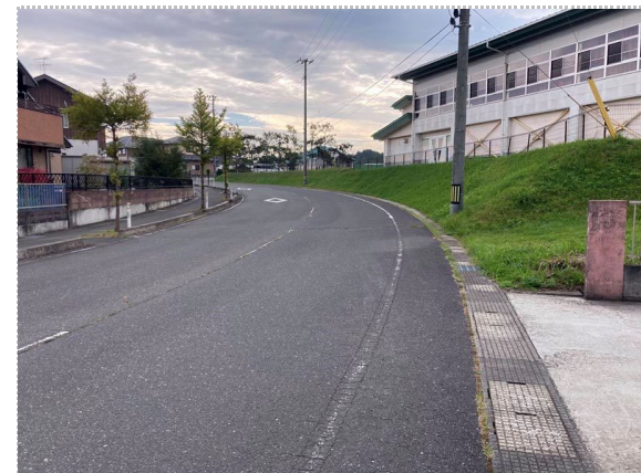
写真7 頭部西側 変状ほぼなし 学校側は盛土範囲外
