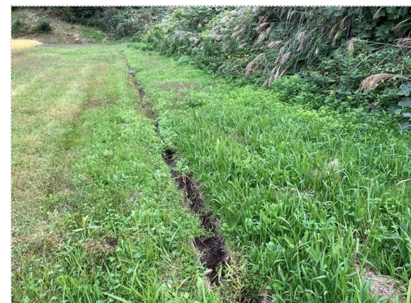
写真46 末端側溝 常時湧水あり
