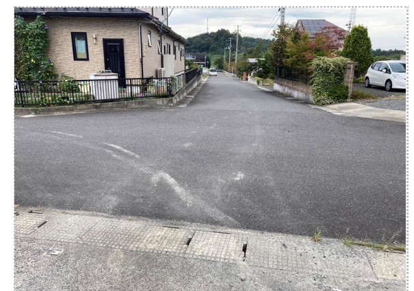
写真32 東側部範囲外 変状なし
