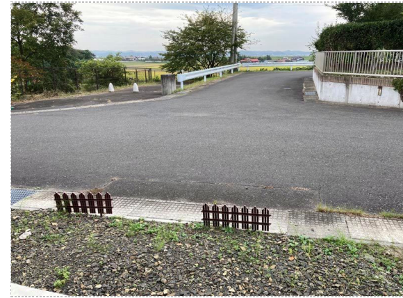
写真34 東側部下流側 末端方向 変状ほぼなし
