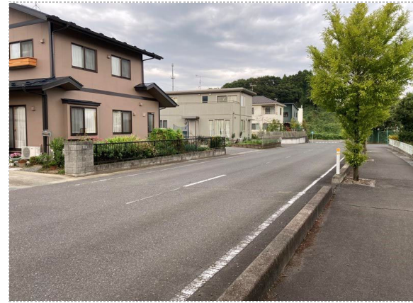
写真2 西側部 頭部方向 路面ひび割れ微小
