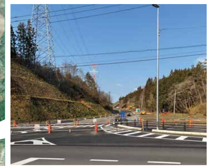
東側道路入口(施工中) 2026年開通予定
