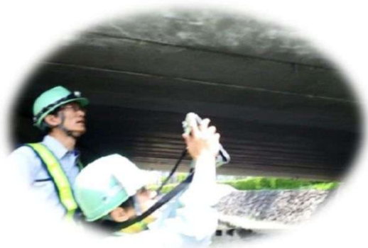
【タブレットによる点検】
