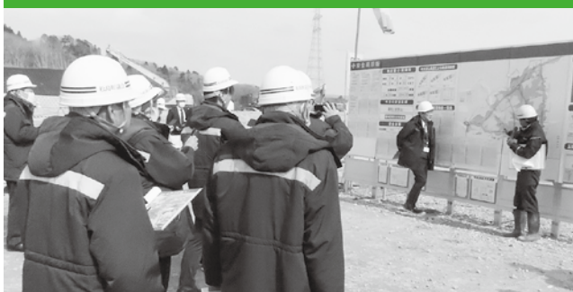
松島イノベーションヒルズ工事現場
