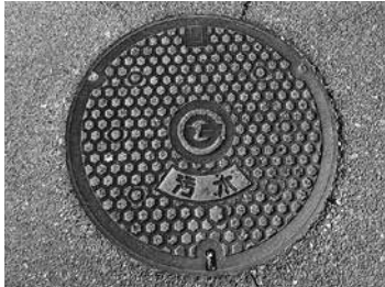
下水道のマンホール
