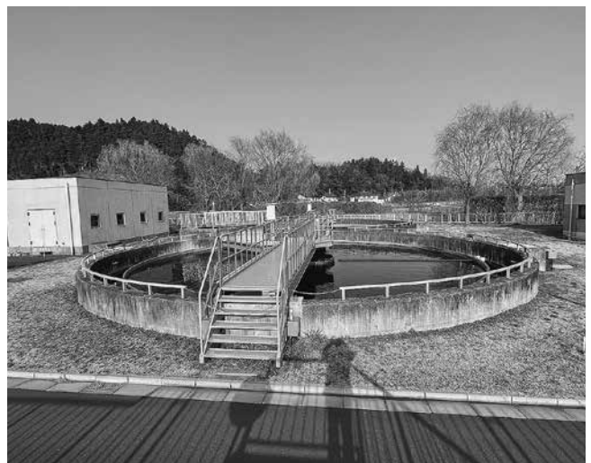
松島町浄化センター
