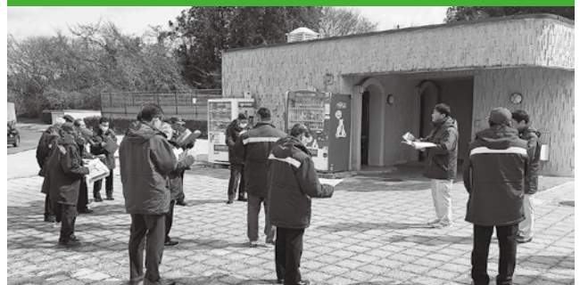
松島運動公園のトイレ洋式化予定箇所
