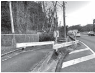
国道45号愛宕地区
