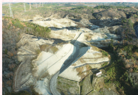
▲整備中の松島イノベーションヒルズ
