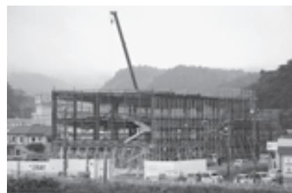
▲建設が進む仮庁舎
