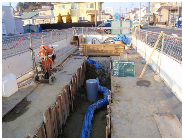
■耐震管への布設替え工事
