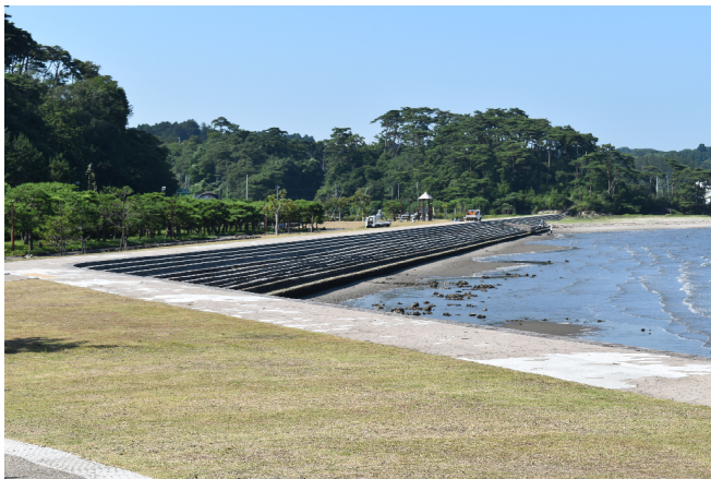
■浪打浜防潮堤整備
