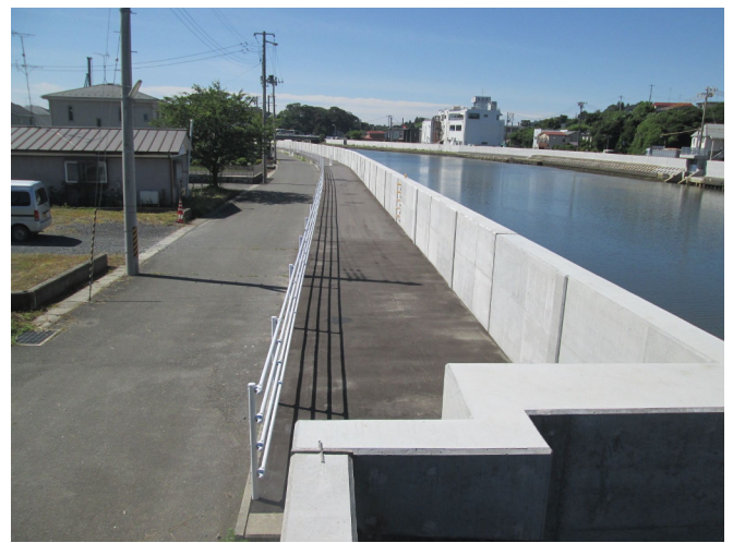
■高城川護岸整備（左岸）
