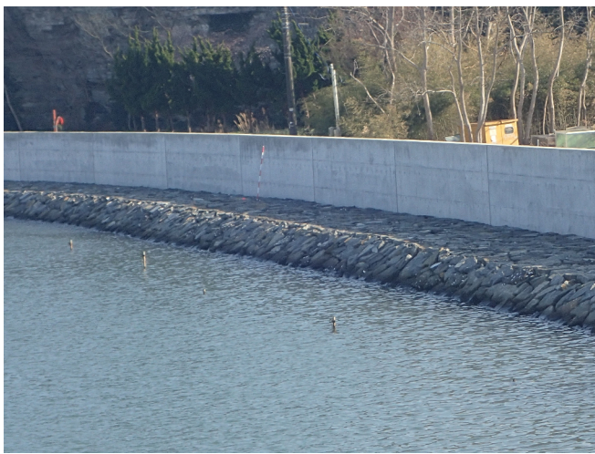
■高城川護岸整備（右岸）
