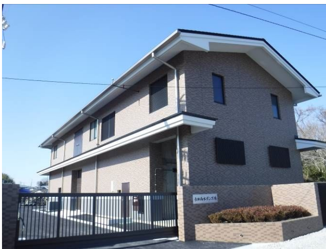
■長田雨水ポンプ場
