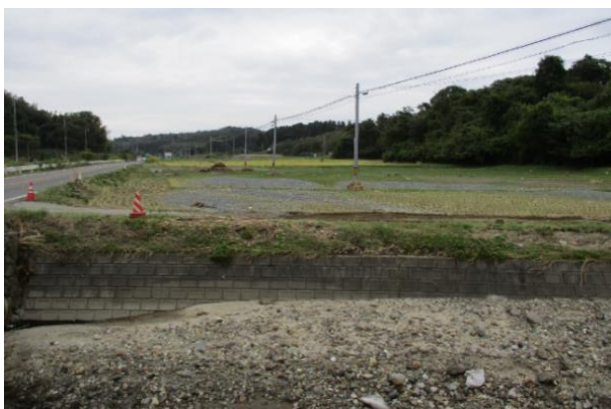
田中川にて越水による水田への土砂流入被害
