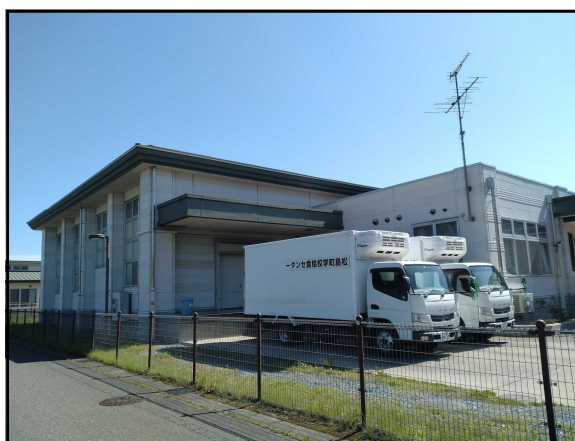
◆配送用トラック
