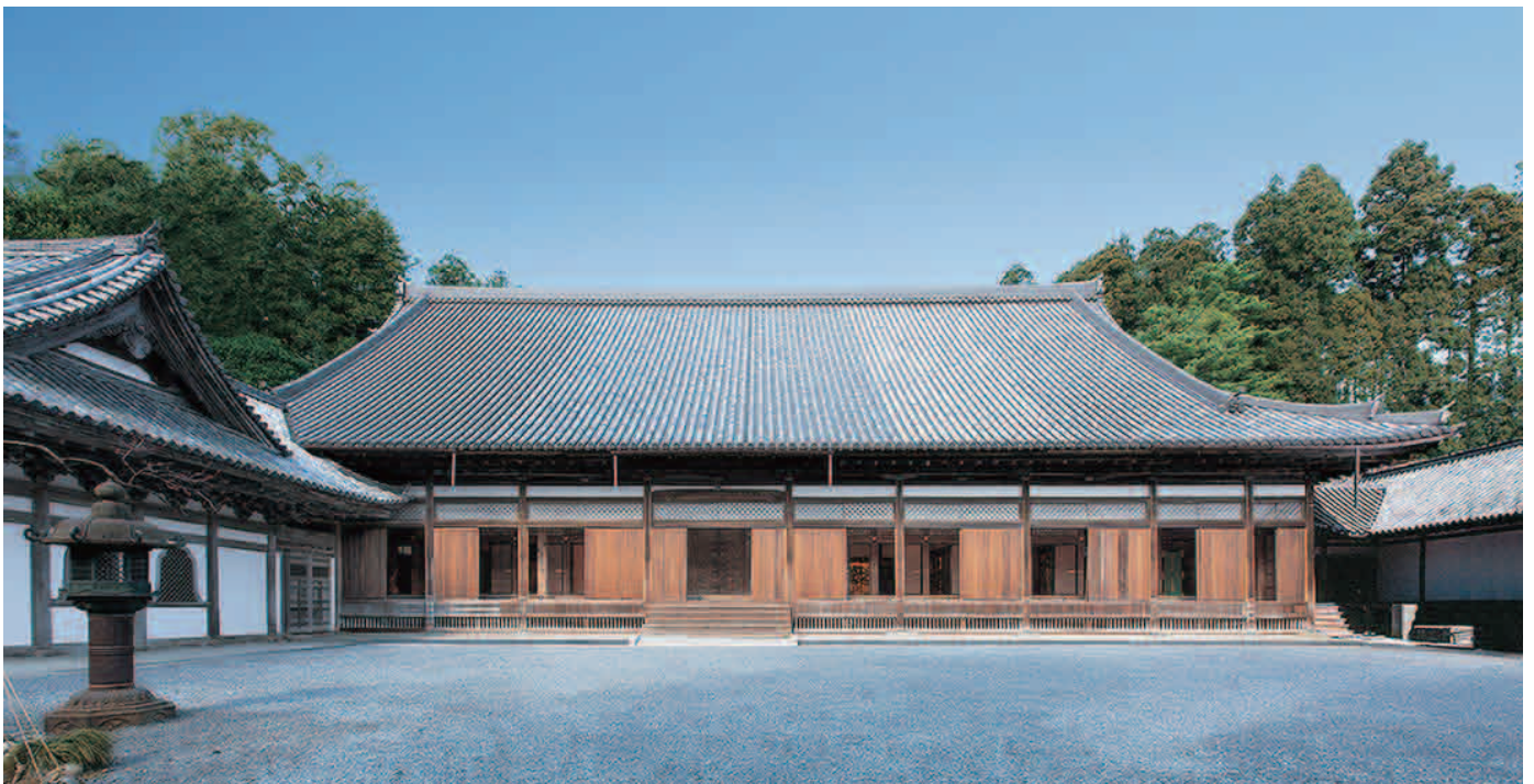
瑞巖寺本堂・庫裡および廊下・障壁画(国宝・国重要文化財)
