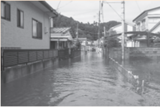
▲冠水した小石浜地区の様子
