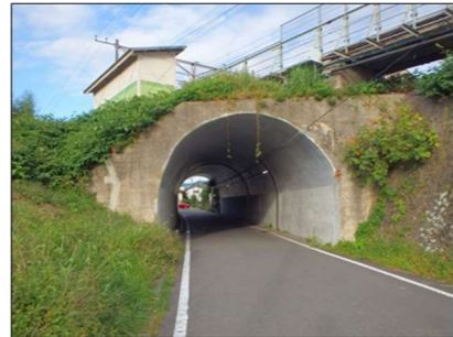
三居山トンネル
