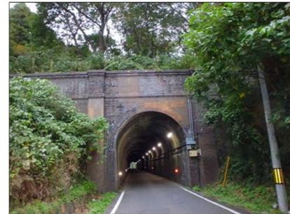
根廻トンネル
