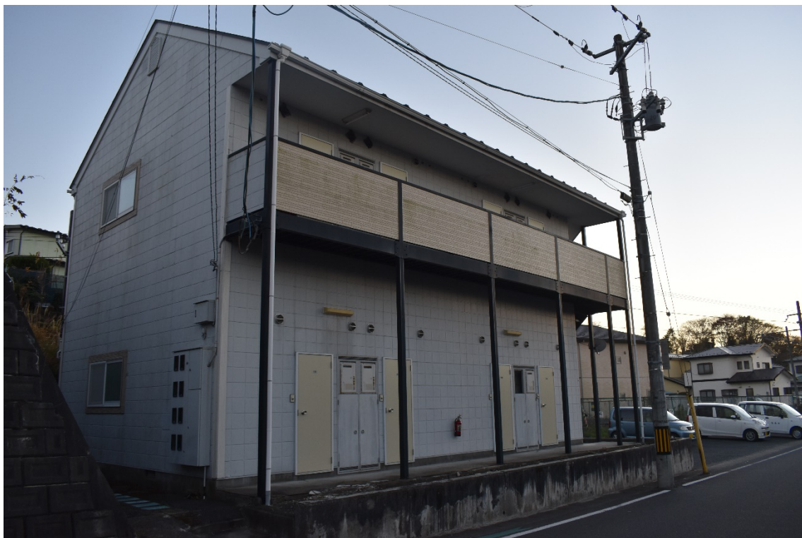
外観①（道路側から）
