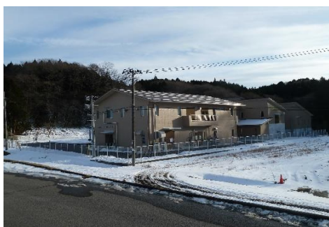
二子屋浄水場
