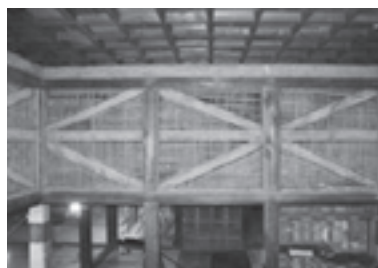
▲壁内部の筋違の様子
