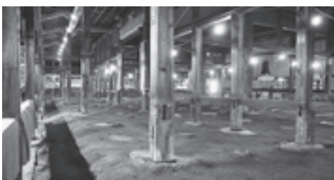
▲発掘調査前、床が外された状態の本堂内部
