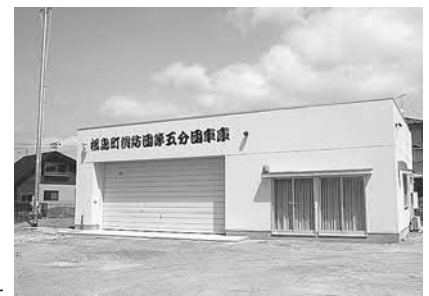
▲新築された第5分団消防車庫
