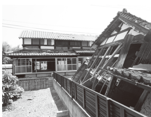
▲御船町内の倒壊した建物
