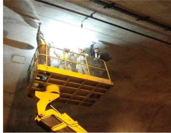
近接目視によるトンネル点検
