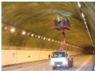
トンネルを定期的に点検し、変状状況を把握。
