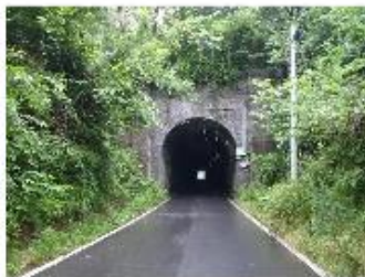
品井沼側坑口
