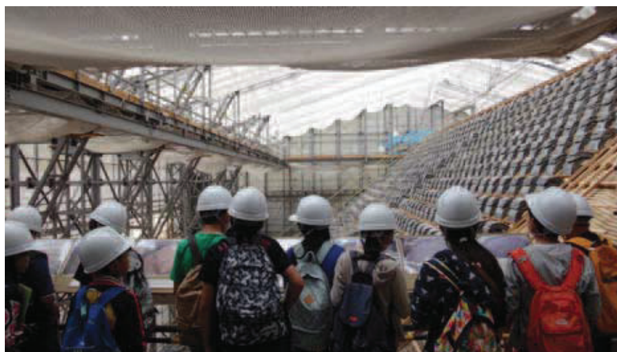
■ 文化財教育(瑞巖寺本堂の修理現場見学)
