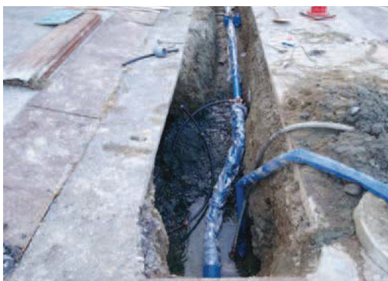
■ 耐震管への布設替え工事
