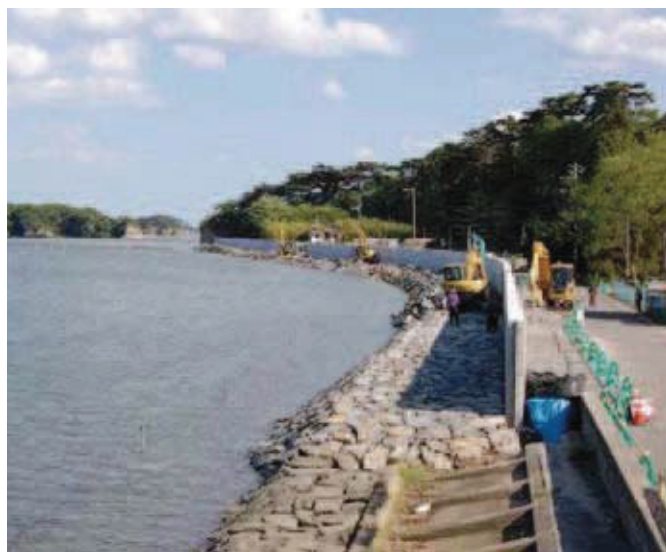
■ 高城川護岸工事 (河口右岸側)
