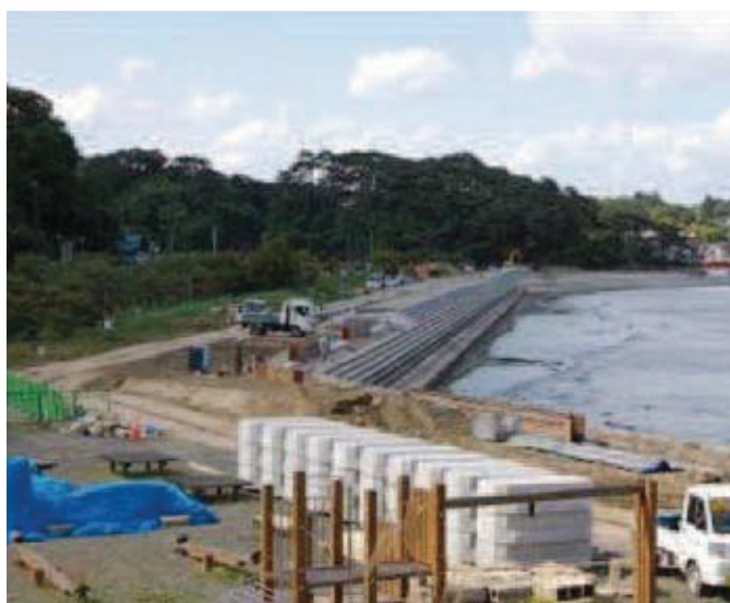
■ 浪打浜防潮堤工事
