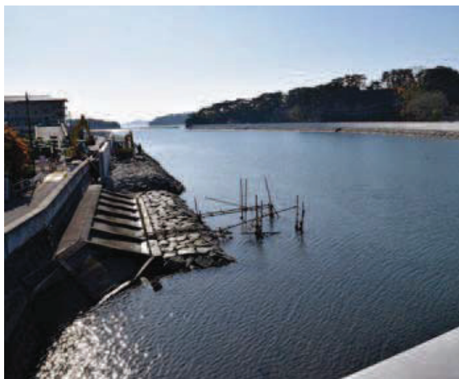
■ 高城川護岸工事 (河口左岸側)
