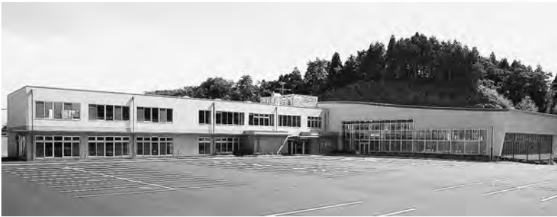
温水プール外観
