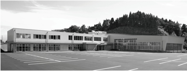
温水プール外観
