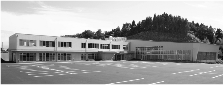
温水プール外観
