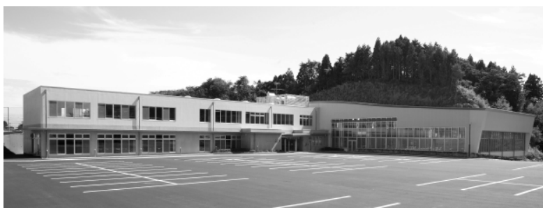
温水プール外観
