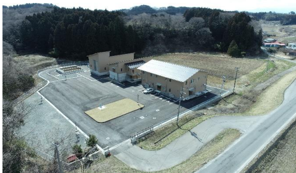
二子屋浄水場
