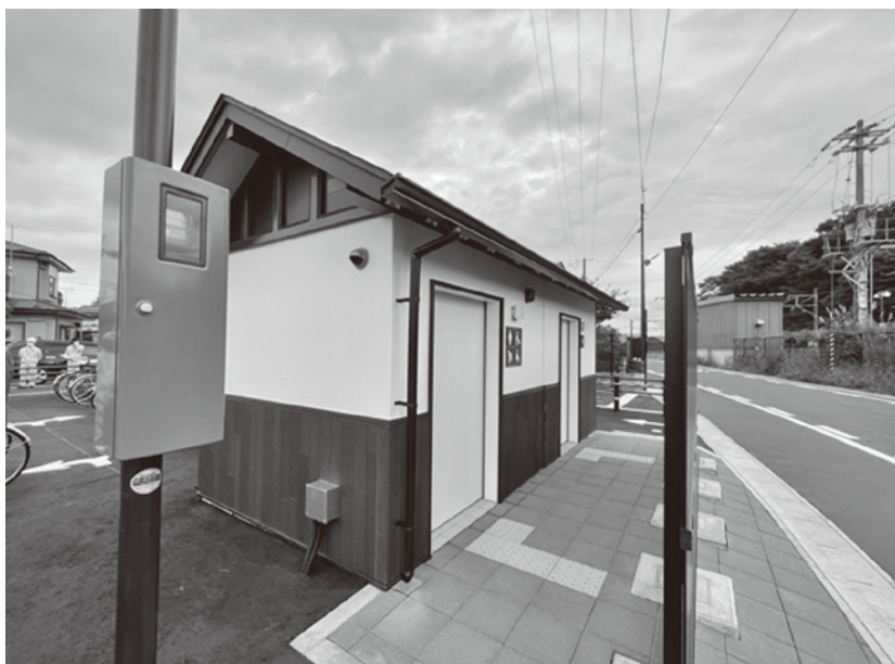
高城町駅前の公衆トイレ
