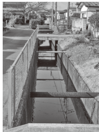
松島郵便局付近の雨水路（高城字町東二）
