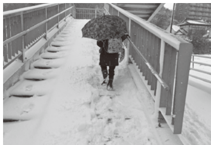
松島第二小学校前歩道橋
