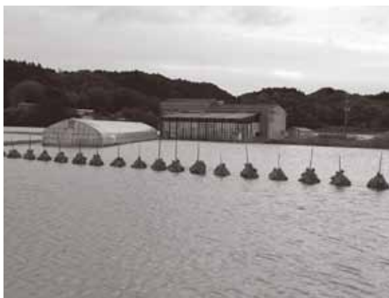
浸水した新弥勒堂地区 (令和元年台風19号被災)
