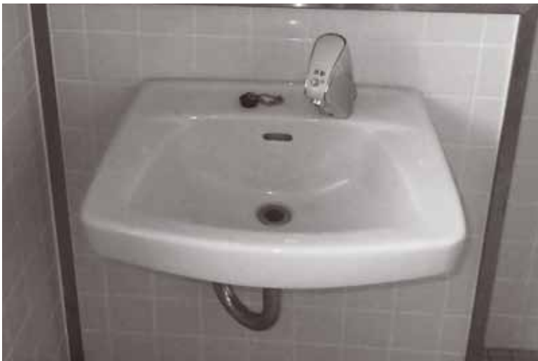
交換された水道の蛇口(第五小学校体育館男子トイレ)
