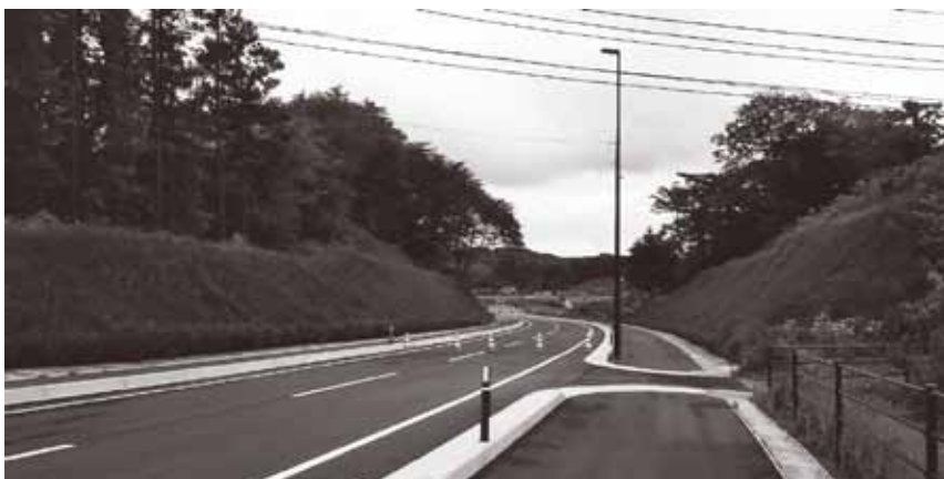
根廻・磯崎線付近
