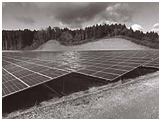
幡谷地区の太陽光発電施設
