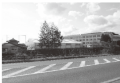
解体される中学校プール
