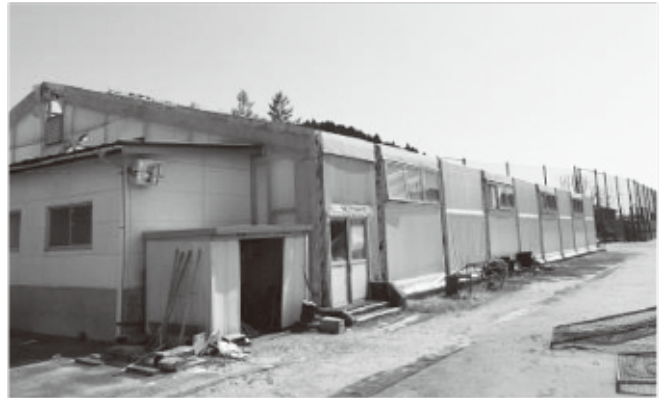
解体される中学校のプール
