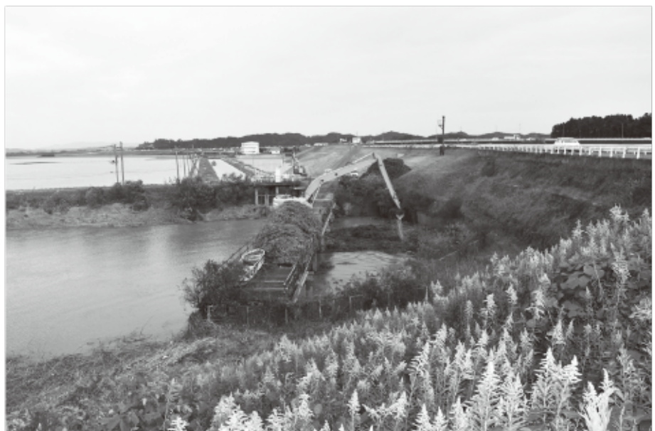
流出した稲わらの撤去作業
