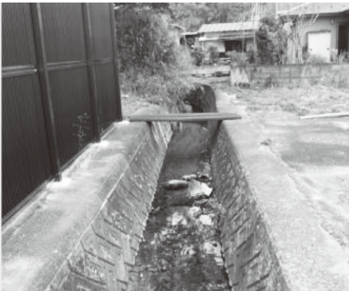
現在の初原地区排水路
