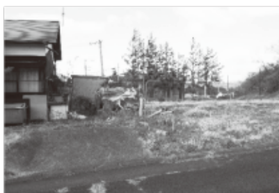
解体される愛宕公営住宅
