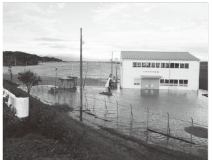
浸水した不來内排水機場
