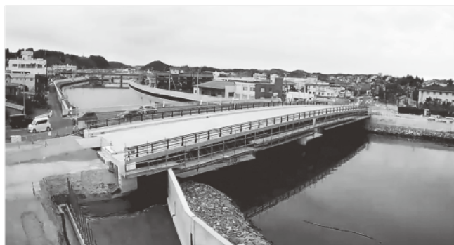
復興事業・松島大橋 (令和2年6月中旬供用開始予定)
