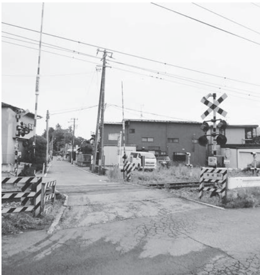
工事をしている磯崎踏切
