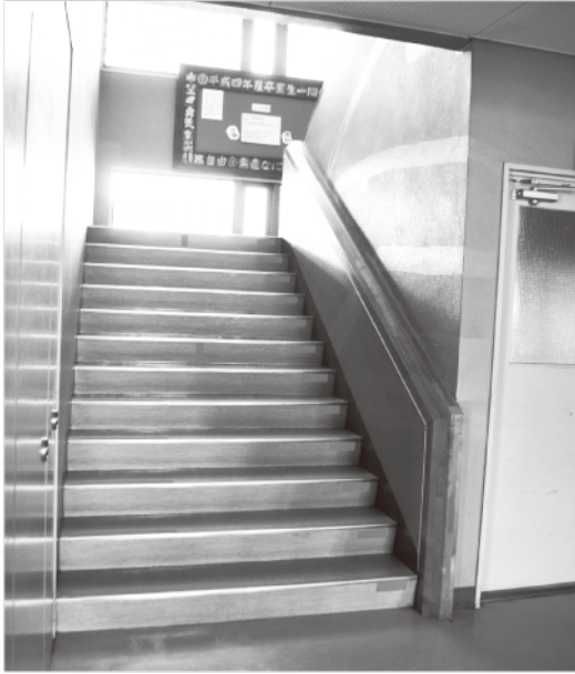
第五小学校 改修予定箇所(階段)
