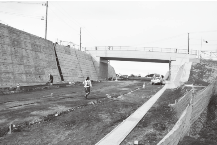
町道根廻・磯崎線（磯崎側）
