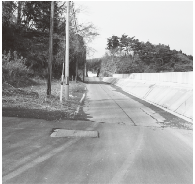
町道手樽・富山駅線避難道路
