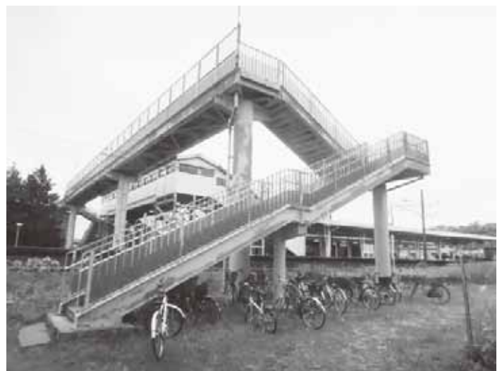
松島駅連絡通路
