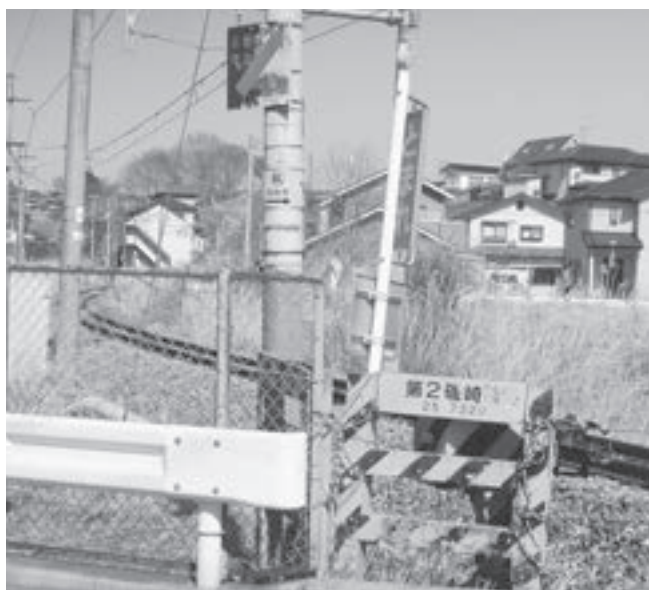
管渠布設が確認された第2磯崎踏切
