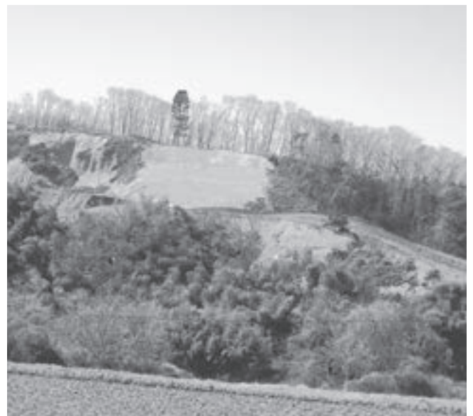
幡谷泉ヶ原地区土取場
