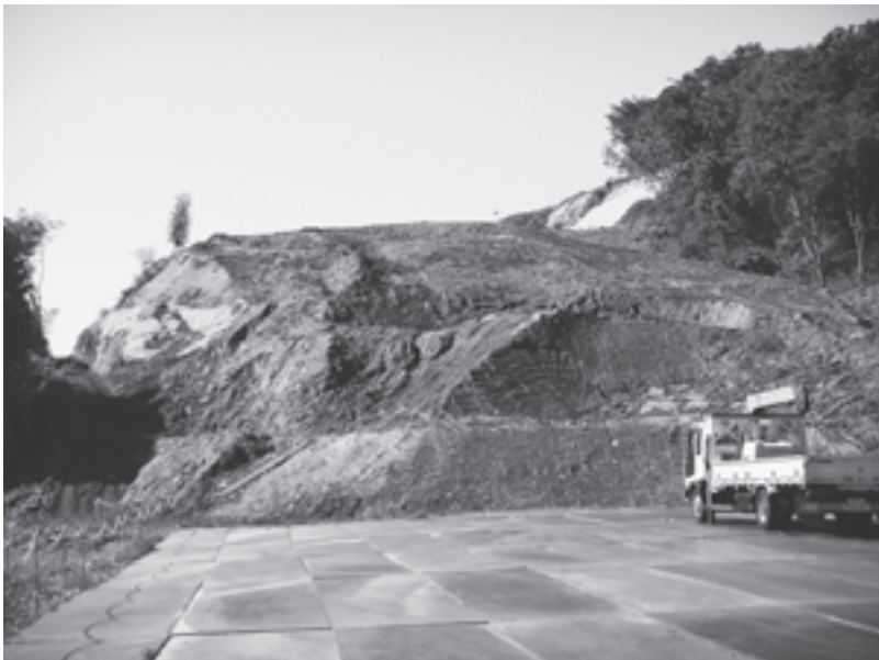
上幡谷の土取り場
