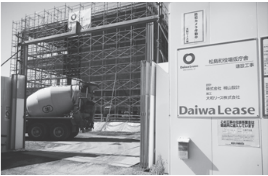
役場仮庁舎建設工事
