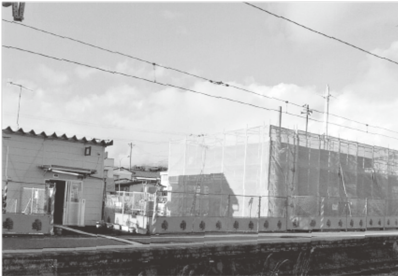
建設中の品井沼駅
