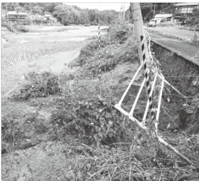
道路土砂流入状況（湯ノ原地区）
