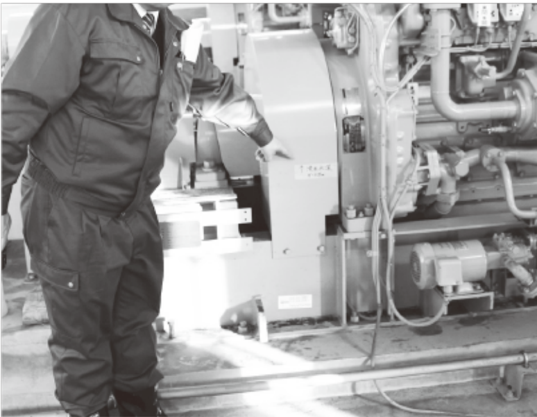
不来内排水機場冠水状況を調査(浸水の深さ75cm)
