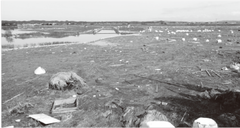
農地冠水および稲わら堆積状況(志田谷地排水機場付近)
