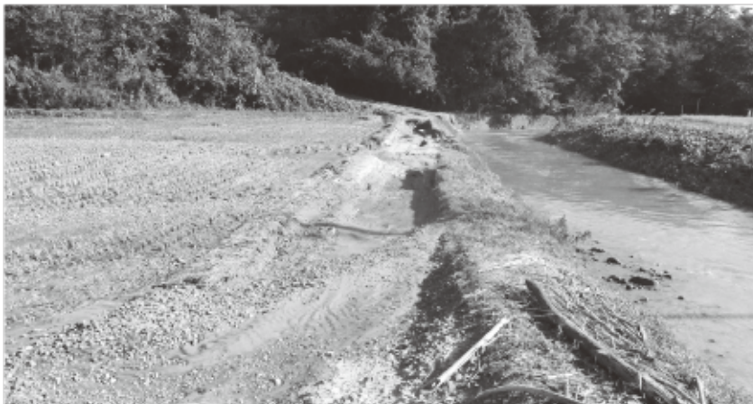
水田への土砂流入状況(桜渡戸字四反田地内)
