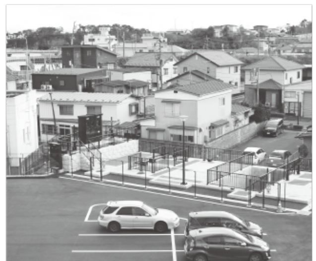
小梨屋ポンプ場（役場前）
