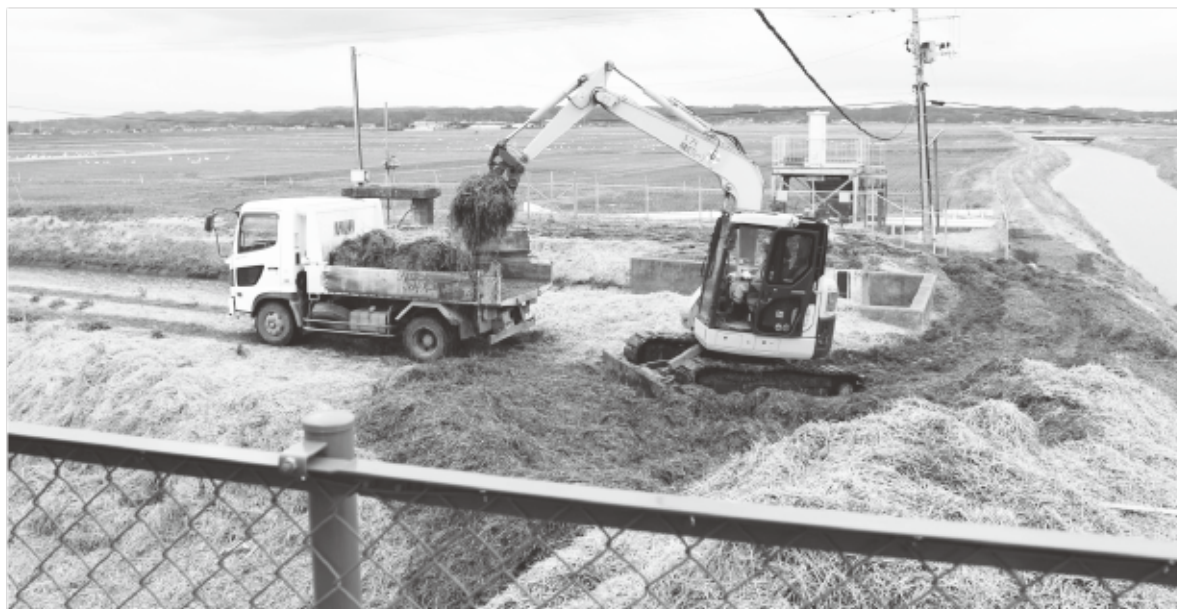
堆積した稲わらの除去作業
