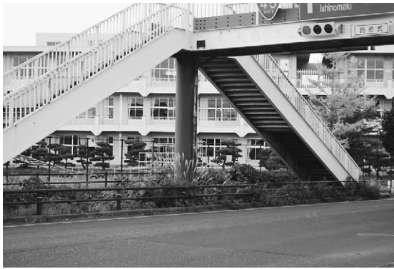
国道45号の歩道橋付近（松一小前）
