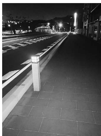
歩道照明灯（国道45号）
