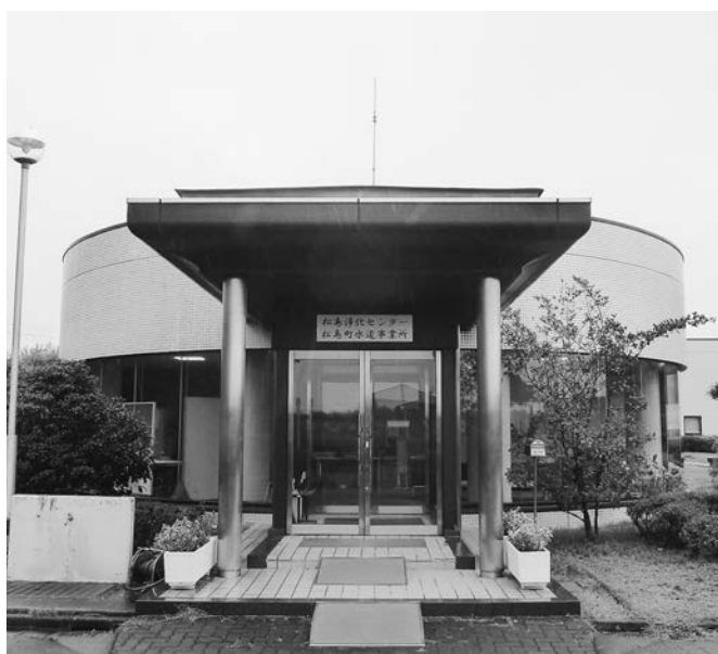
松島浄化センター
