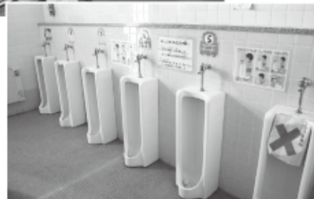
第五小学校改修予定箇所
