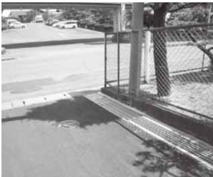
事故があった側溝（現在は改修済み）
