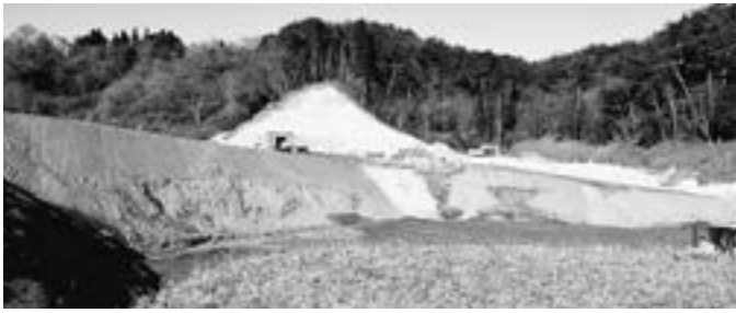
三十刈避難施設建設地
