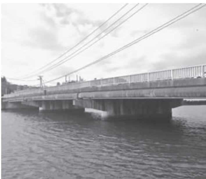
松島大橋（水道橋）
