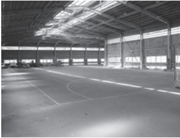
耐震工事が行われる松島フットボールセンター無床体育館
