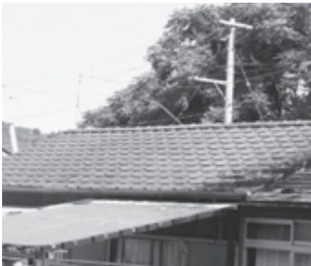
耐震化のためにトタン屋根に葺替えられる町営住宅上初原団地
