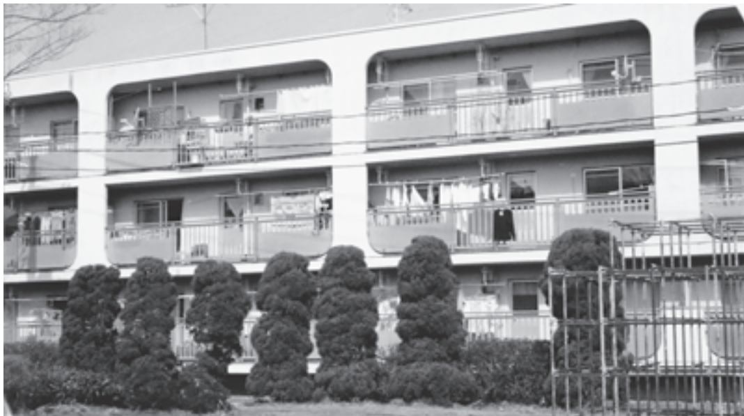
町営高城住宅
